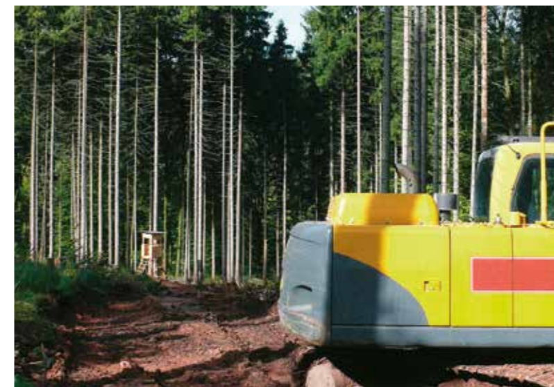
Wegebau im Südharz Foto: Lutz Döring
