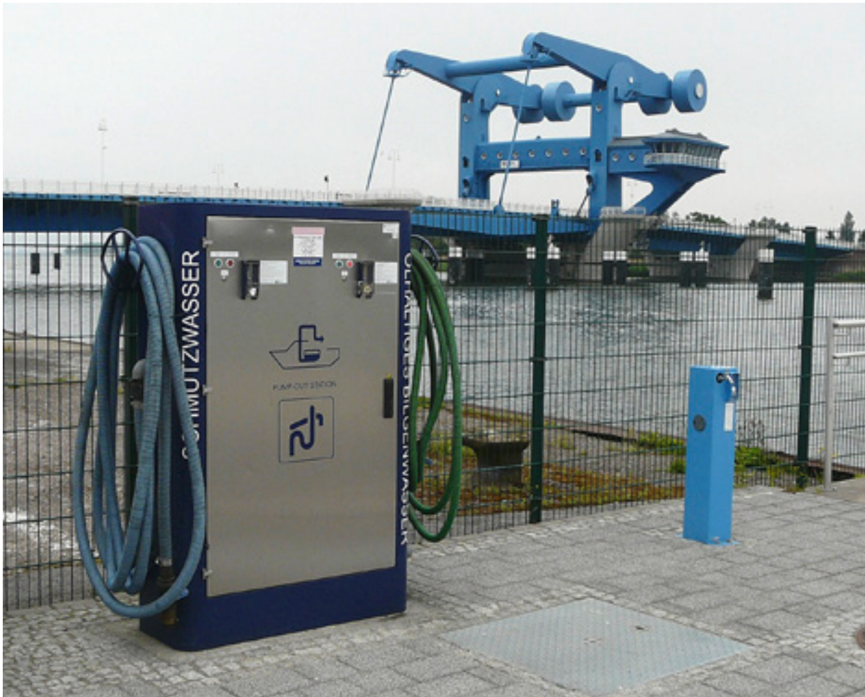
Pump-out-Station im Stadthafen Wolgast
