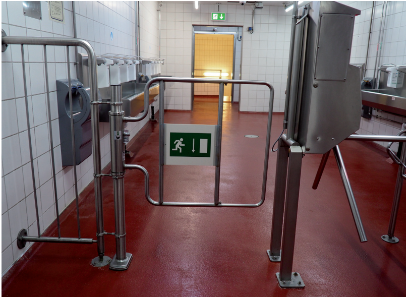
Abb. 5: Hygieneschleuse mit Fluchttür
