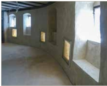
Schießgang. Über dem Fußboden die drei geöffneten Wurflöcher. Die Fenster stammen aus einer späteren Bauphase.
