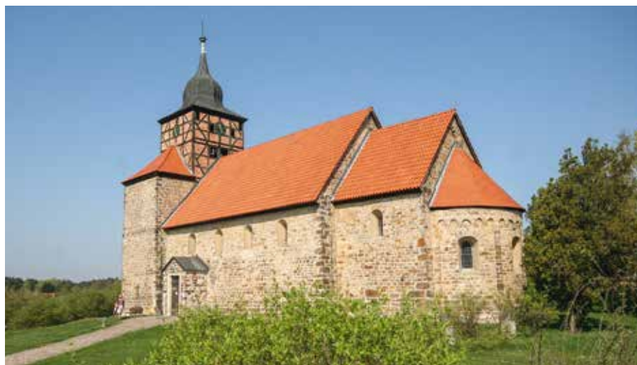
Im Auftrag Albrecht des Bären errichtet: die Pretziener Bruchsteinkirche, Foto: W. S.
