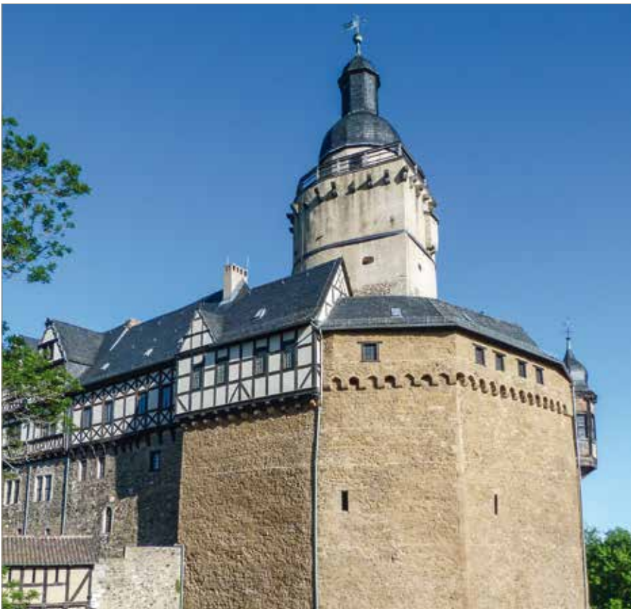
Die Schildmauer nach der Sanierung 2020. Deutlich erkennbar die beiden Schlitzscharten in der Mauer. Hinter dem obenliegenden Konsolfries befindet sich der Schießgang.
