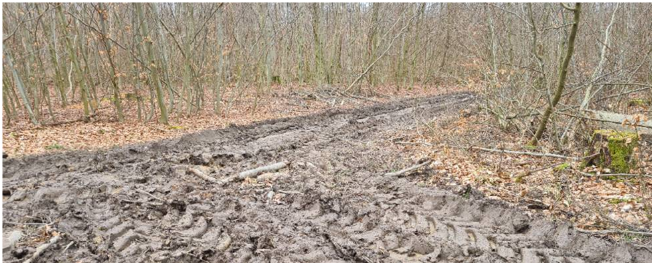
Beschädigte Wanderwege © Liane Jordan/Deutscher Wanderverband Service GmbH
